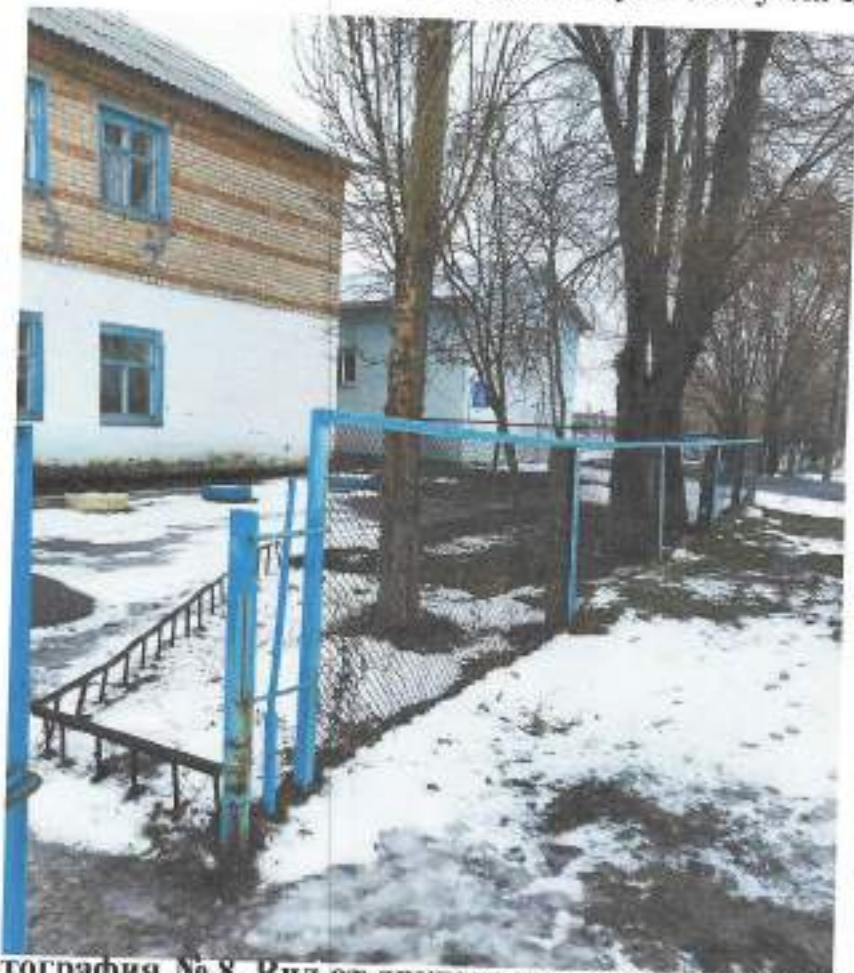
Фотография № 7. Вид от калитки до следующего угла здания
